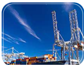
NAVEGACIÓN, CARGA Y PUERTOS
